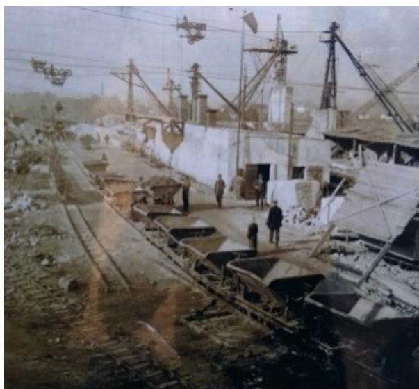
Bau von in Deutschland bis dahin unbekanntem Kabelhochbahnen
